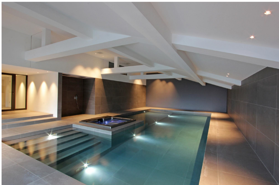
Rénovation complète d'une piscine intérieure datant d'une trentaine d'années construite dans le chalet d'une station de montagne. CARRÉ BLEU : NICOLLIER Piscines à Fully & Genève (CH)- Architecte : ARCHI-DT SA
