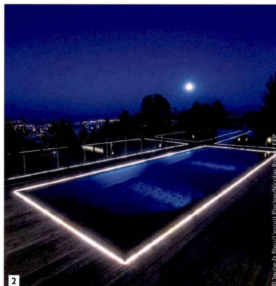
**2 - Trophée d'Argent : Jaune et Bleu/ L'Esprit Piscine** pour cette piscine miroir de 10,25 x 3,50 m. Structure en béton armé. Système d'éclairage : projecteurs à led + leds intégrés dans la goulotte de débordement périphérique de la piscine. Revêtement : membrane armée 150/100<sup>e</sup> noir. Plages : bois. Margelle : pierre naturelle. Options : régulation auto, chauffage, projecteur, volet immergé, escalier.
