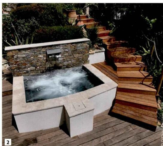
**2 - Trophée d'Argent : Diffazur Piscines** pour ce spa rectangulaire de 4m<sup>2</sup>, profond de 1,10 m, en béton armé et gunite. Revêtement : Crystalroc Granité® Gris galet Impérial Silver (enduit minéral à base de cristaux quartz et de marbre).
