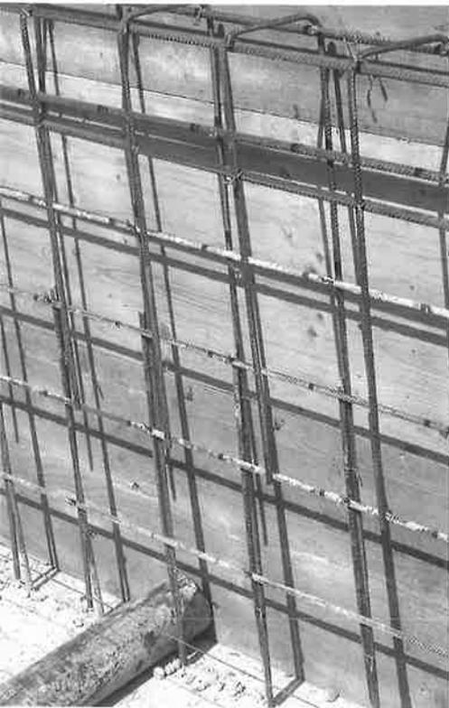
▲ Coffrage et ferrailage avant la pose du coffrage de parement.
