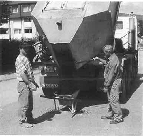
▲ *L'enrobé est déchargé progressivement du camion silo, afin de ne pas refroidir rapidement.*
