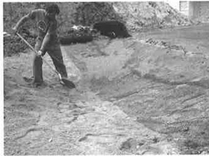
▲ Mise en place d'une couche de sable et treillis anti-rongeurs.
