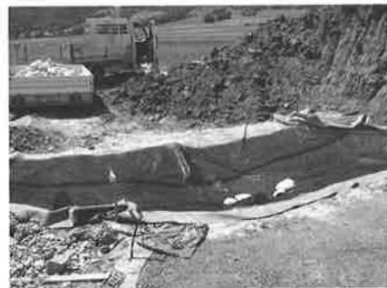
▲ Mise en place d'une natte de talus. Ce treillis synthétique a une double fonction, 1 protection mécanique, 2 évite le glissement des galets.
