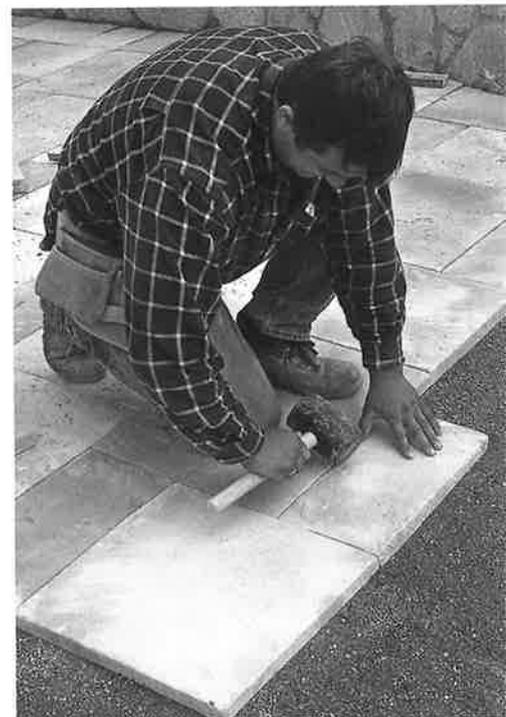
▲ Pose de dalles sur un lit de pose, composé de sable 0 – 8 stabilisé avec de la chaux et du ciment.
